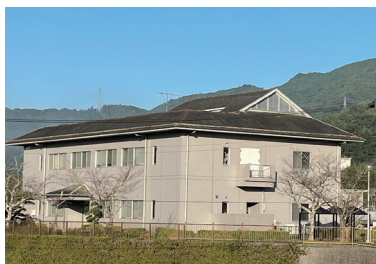
大洲市 こうなん 肱南 か じょう化センター (西大洲)
