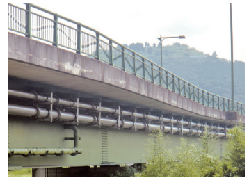
かん 橋のそく面を通る配水管
