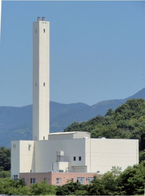
大洲市環境センター（八多喜）
